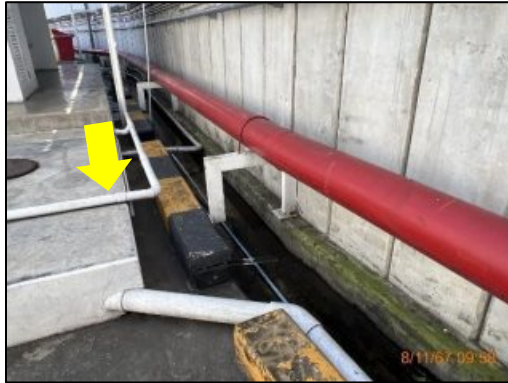
รูปที่ 2-48 ท่อระบายน้ำปนเปื้อนจากจุดพักขยะเข้าสู่ระบบบำบัดน้ำเสีย
