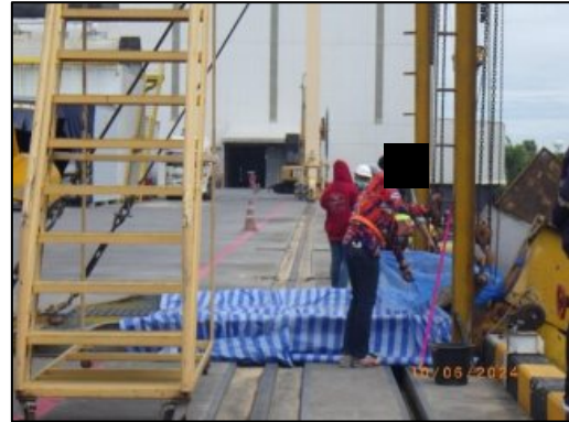
รูปที่ 2-2 การชิงผ้าใบหน้าพลาสติกระหว่างเรือลำเลียงสินค้าและท่าเทียบเรือ
