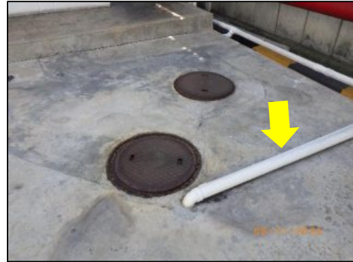
รูปที่ 2-48 ท่อระบายน้ำปนเปื้อนจากจุดพักขยะเข้าสู่ระบบบำบัดน้ำเสีย
